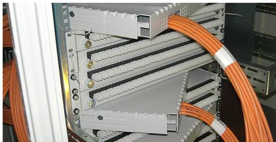
Foto: Netzwerkverteiler mit Glasfaserleitungen, Quelle: K.-H. Peil
